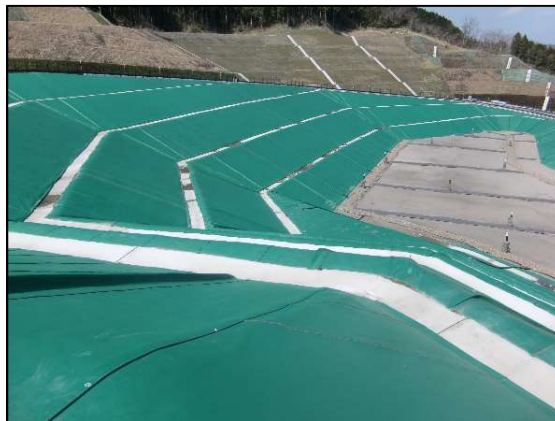
写真 6 表面遮水工の整備例
