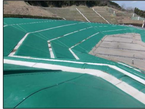
写真3 表面遮水工の整備例
