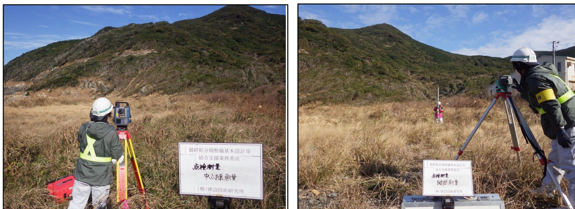
写真 1 測量調査状況の例
