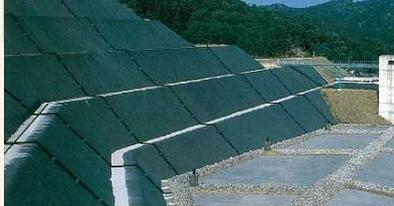
埋め立てたごみを通った雨水(浸出水)が地下水へ流れ込まないようにシート等を敷設します。
