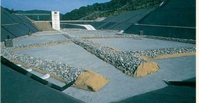
ごみを通った雨水(浸出水)を速やかに集めて浸出水処理施設まで導水します。
