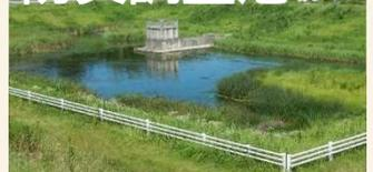
最終処分場に降った雨を一時的に貯留するための池を設置します。
