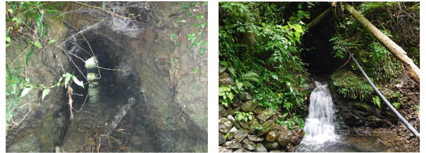
図 7 道路横断水路、南側エリア（左：隧道内部、右：田代川側出口隧道）
