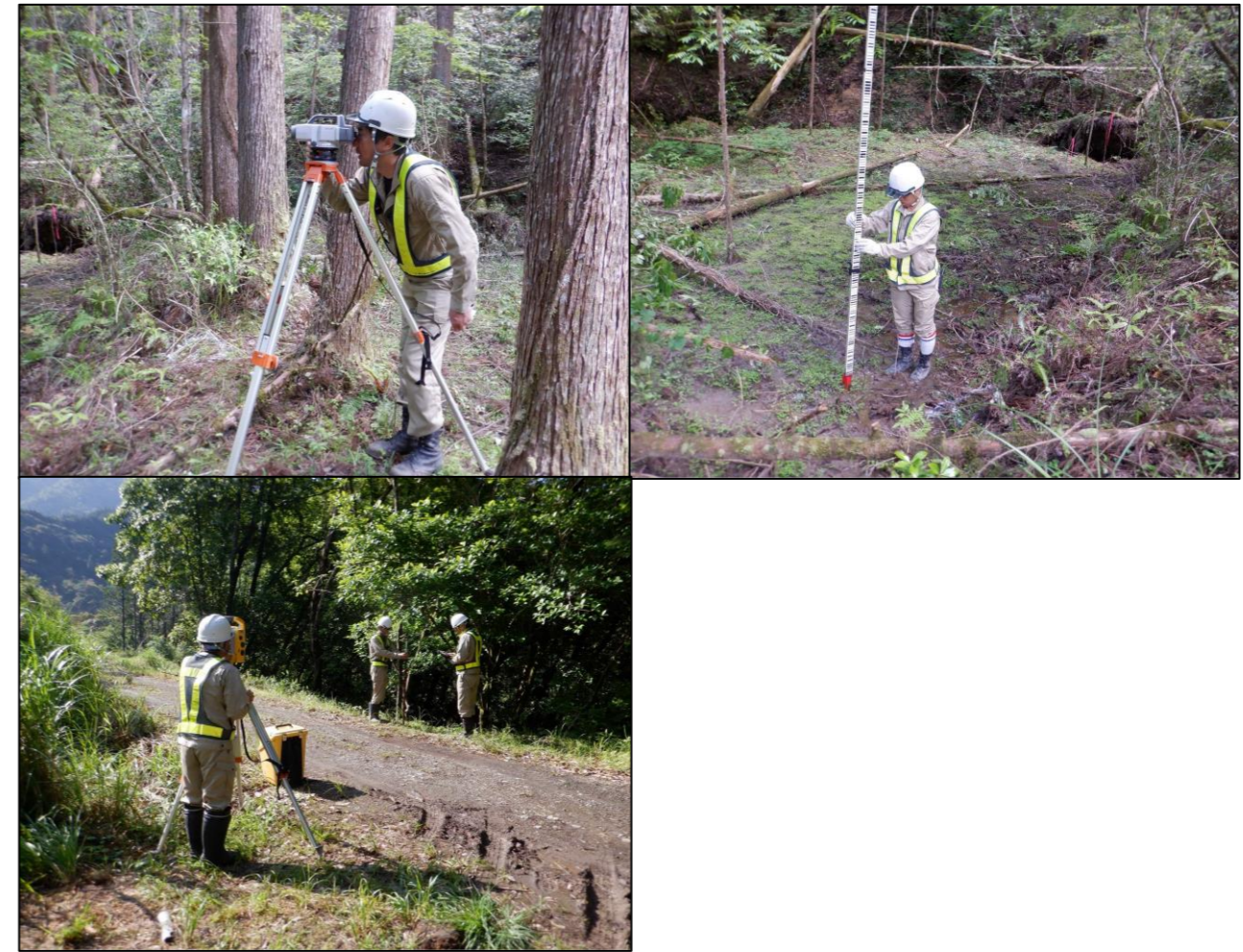
写真 3 測量調査状況の例
