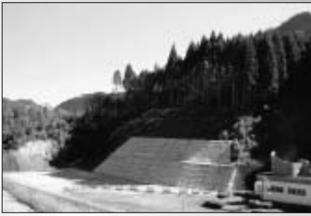
造成工事を終えた建設予定地（右下は現在の霊苑）
