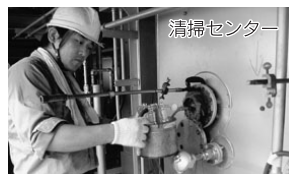
火格子改修工事、ダイオキシン類測定分析、煤煙測定分析(写真)、各種機器保守点検などを実施
