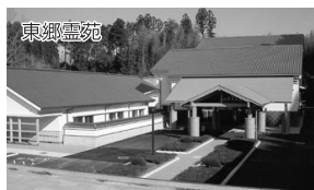
平成17年3月、斎場施設が完成
