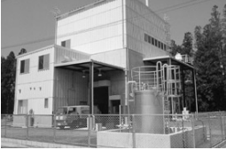
美郷町西郷区のごみ処理施設 年間約330トンのごみを処理しています。
