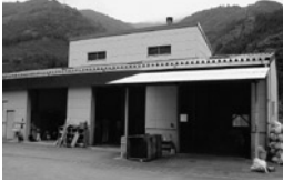
椎葉村のごみ処理施設 年間約490トンのごみを処理しています。
