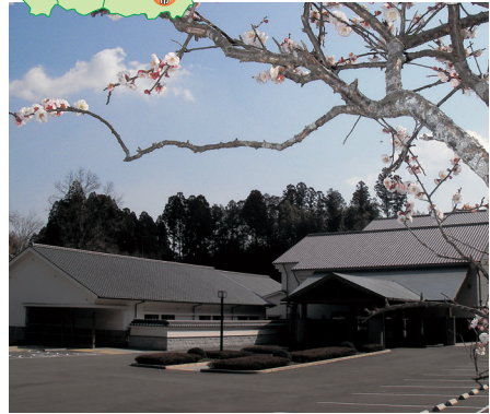
平成17年度に完成した火葬場です。
