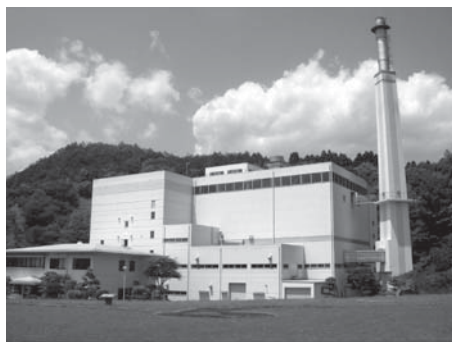
長寿命化工事（第2期）を施工する清掃センター
