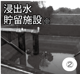
埋立物の間を通った雨水（浸出水）を一時的に貯留施設に溜め、処理施設にて国の定めた基準値以下まで処理します。
