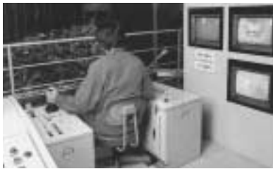
24時間完全連続運転 燃焼温度を安定させ、ダイオキシン類の発生を防ぎます。
