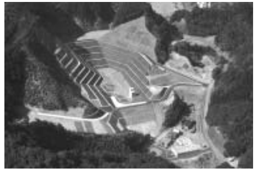
オープン型最終処分場の例(日向市)
